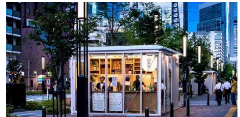
広い歩行者空間を活用した道路内建築の設置（新虎通り）
