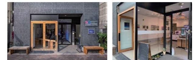
まちなかショーケースとしての新虎小屋
