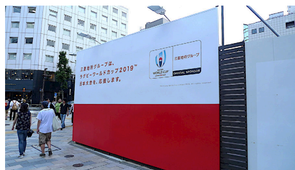
協賛イベントのPRも兼ねる工事仮囲い
