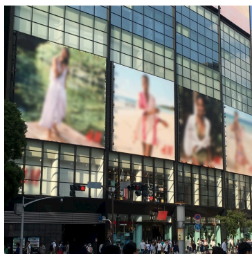
大きすぎ眩しすぎる広告物
