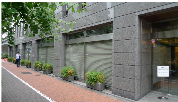
ガラス面が固く閉ざされている
