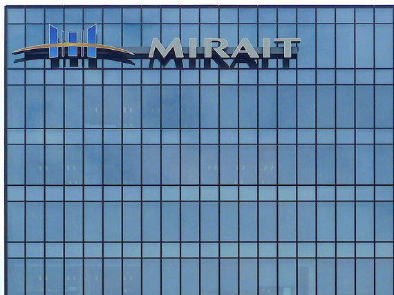
ガラスのカーテンウォールの壁面にロゴと社名をシンプルに配置した例
